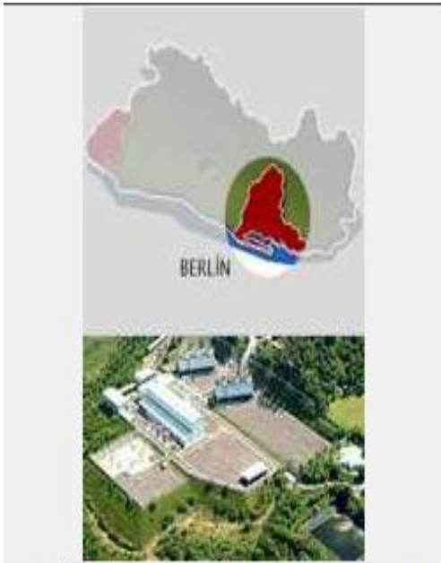
BERLÍN. Vista aérea de la Central Geotérmica.
